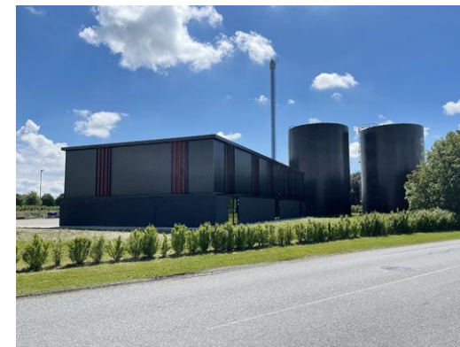
Lagerbygning, Løsning Fjernvarme
