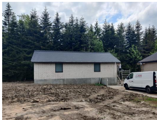
Pumpebygning, Horsens Fjernvarme
