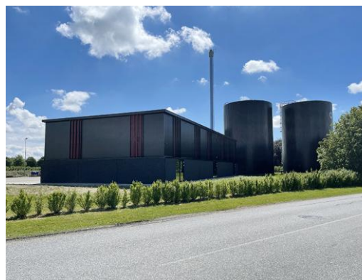
Lagerbygning, Løsning Fjernvarme
