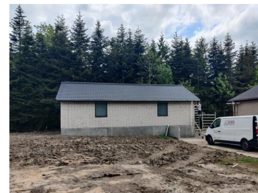
Pumpebygning, Horsens Fjernvarme
